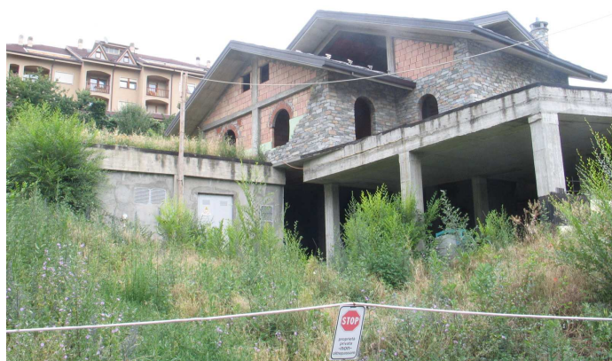
a) edificio vicino a cabina MT/BT
