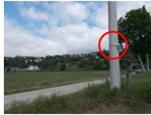
2 Strada La Bassa
