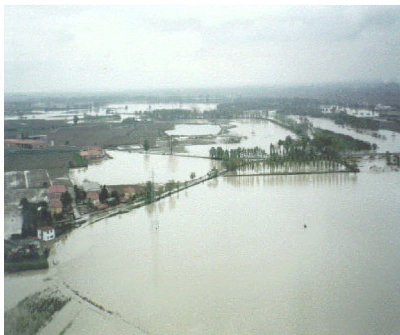
Esondazione del Torrente Scrivia il 23 ottobre 1999: bivio della strada comunale per Sale con la strada provinciale per Guazzora
