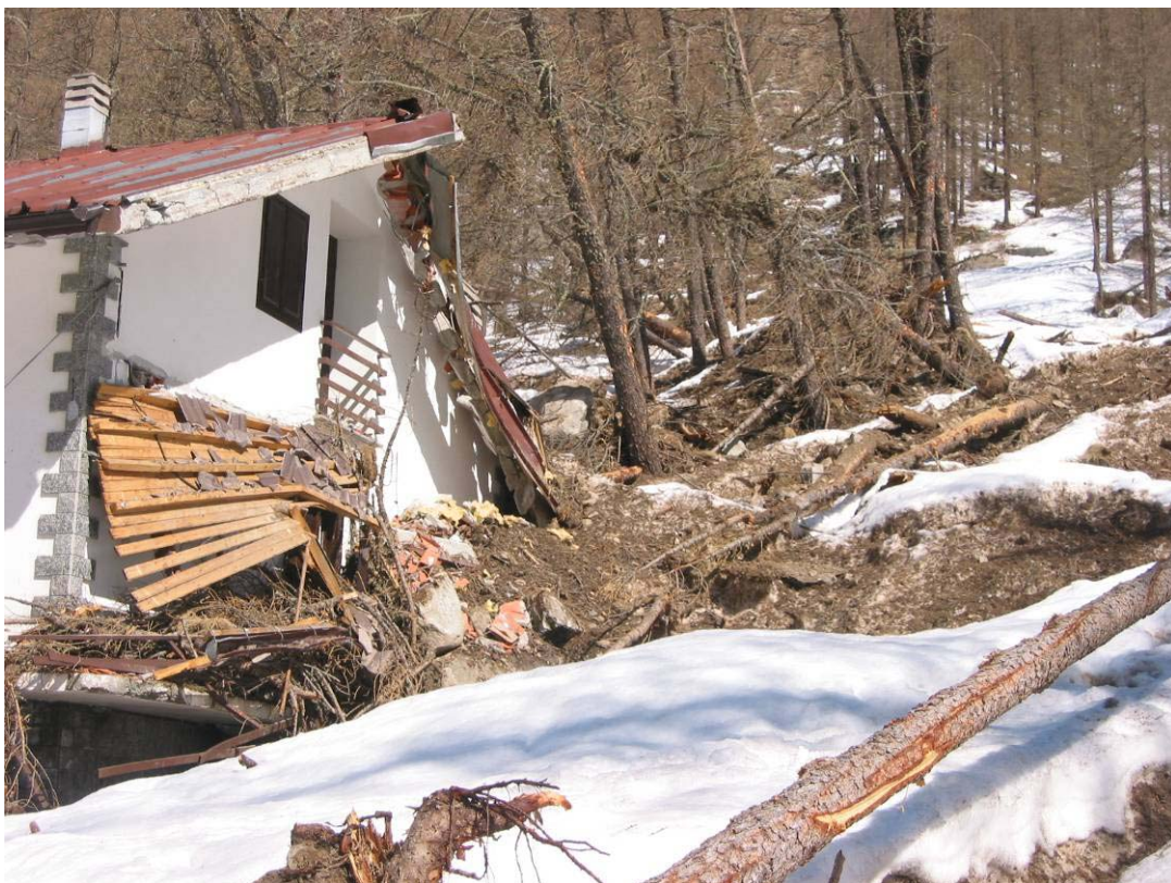
Figura 4. Effetti di trasporto di tronchi di larice da parte di una valanga di neve a debole coesione in Ceresole Reale (TO).
