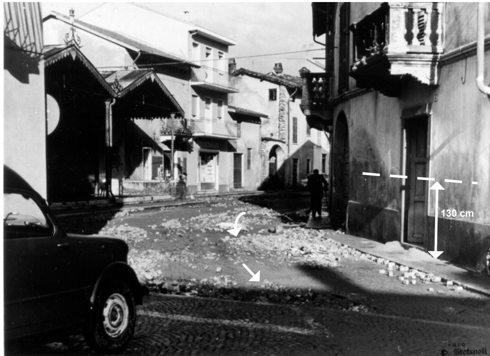
Fig. 3 Carpignano Sesia: inondazione del novembre 1968; altezza raggiunta dalle acque fuoriuscite dal Cavo Busca. Le frecce bianche indicano la direzione della corrente
