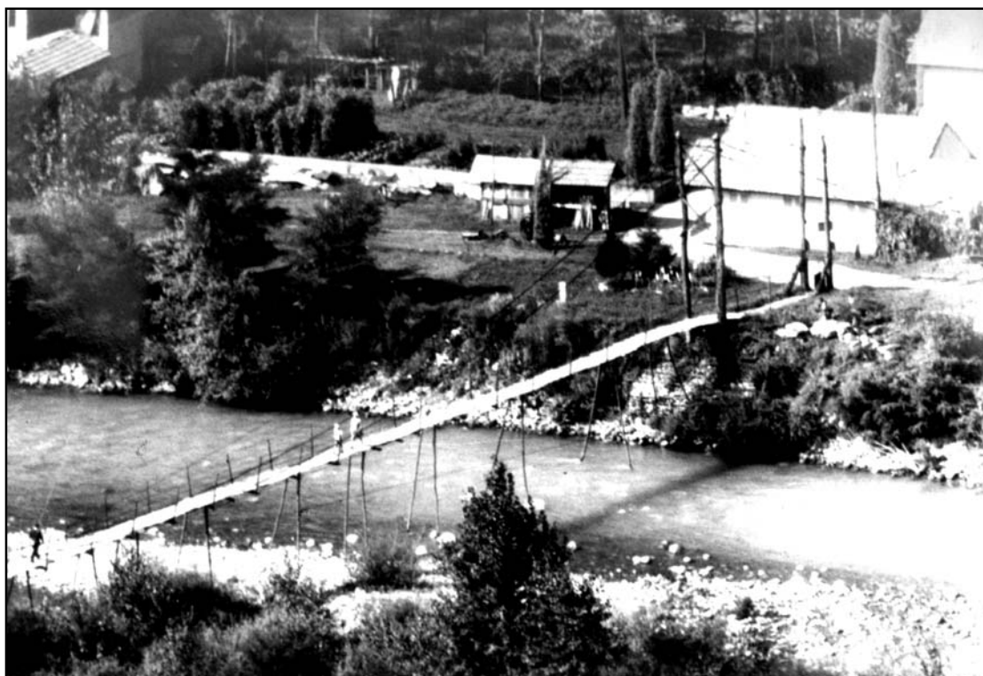
Fig. 15. Comune di Serravalle. La passerella sospesa Grignasco-Serravalle prima dell'alluvione del novembre 1968. Fotografia di proprietà della Dr. Mazzone che le ha avute in dono dal sig. Roberto Biglia. Foto Bussi.
