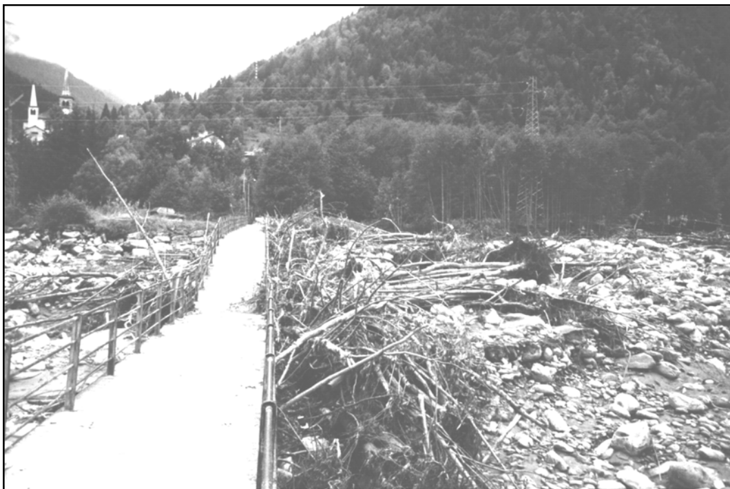
Fig. 27. Comune di Riva Valdobbia. Il ponte per la frazione Gabbio dopo il cedimento del pilone. Si osservi la grande quantità di relitti vegetali che il fiume ha ammassato a monte.
