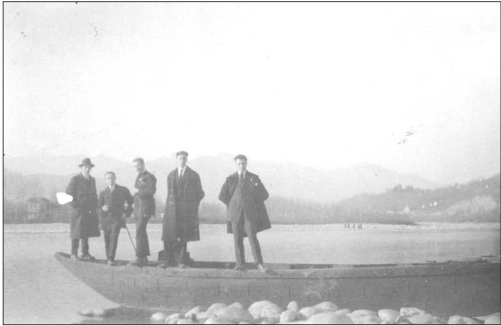
Fig. 11. Comune di Serravalle. Fotografia ripresa durante i lavori di ricostruzione del ponte dopo la piena del 1934. Fotografia di proprietà della Dr. Piera Mazzone, che le ha avute in dono dal sig. Roberto Biglia.
