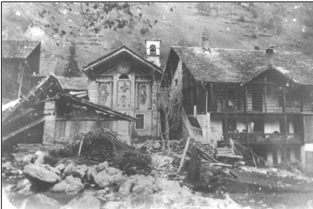
Fig. 12. Comune di Alagna. Frazione Pedemonte dopo la piena del torrente Mud.
