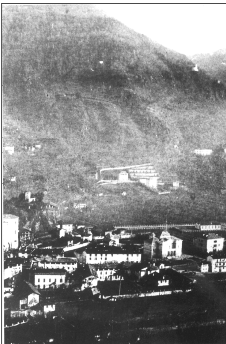
Fig. 34. Comune di Varallo. La zona della tragica frana del 6 novembre 1994 in una fotografia di fine '800. Si vede la casa distrutta e i terrazzamenti che la sovrastano, con la strada che portava alla villa Geniani.
