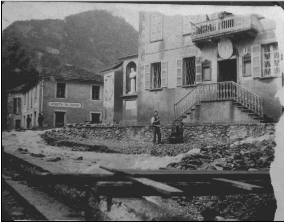
Fig. 8. Comune di Fobello. La piazza e il municipio di Fobello dopo l'alluvione.
