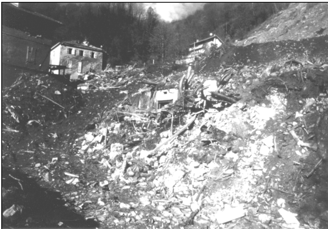
Fig. 34. Comune di Varallo. La frana che si abbatté su tre abitazioni nella notte tra il 5 e il 6 causando la morte di 14 persone.
