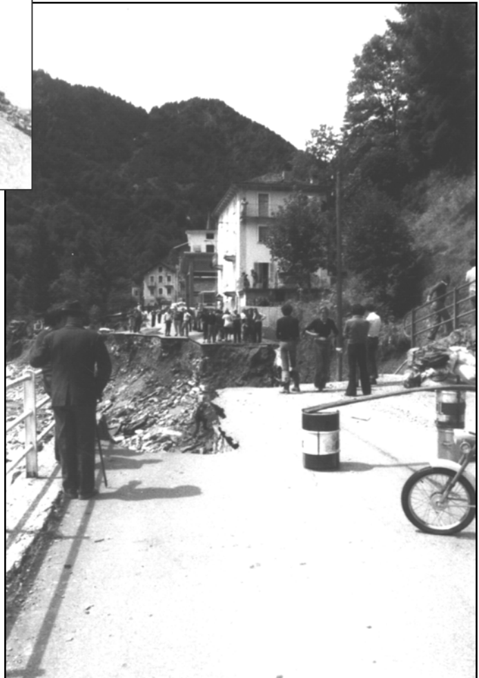
Fig. 22. Comune di Fobello. Val Mastallone. Danni alla strada provinciale a poca distanza da Fobello
