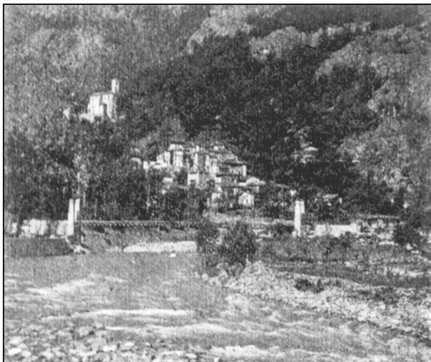
Fig. 4. Comune di Varallo. Il ponte sospeso sulla Sesia tra la Balangera e Morca distrutto da una piena nel 1918. Venne ricostruito dieci anni dopo aumentandone la luce.
