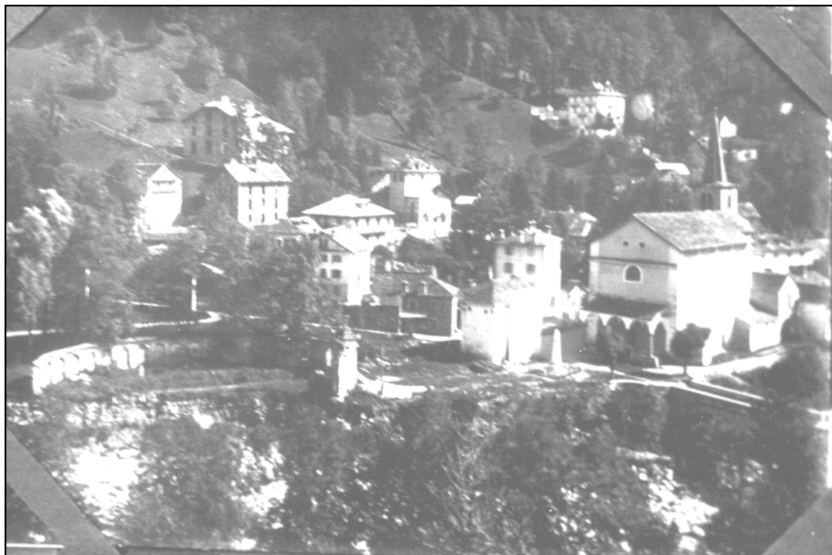
Fig. 5. Comune di Fobello. A sinistra nella foto si scorge la cinta del cimitero vecchio in parte asportato dall'alluvione del 1919. Sulla destra, la chiesa del S. Sepolcro, il monumento ai Caduti e la chiesa parrocchiale; i primi due vennero distrutti e l'altra gravemente danneggiata nel 1923.
