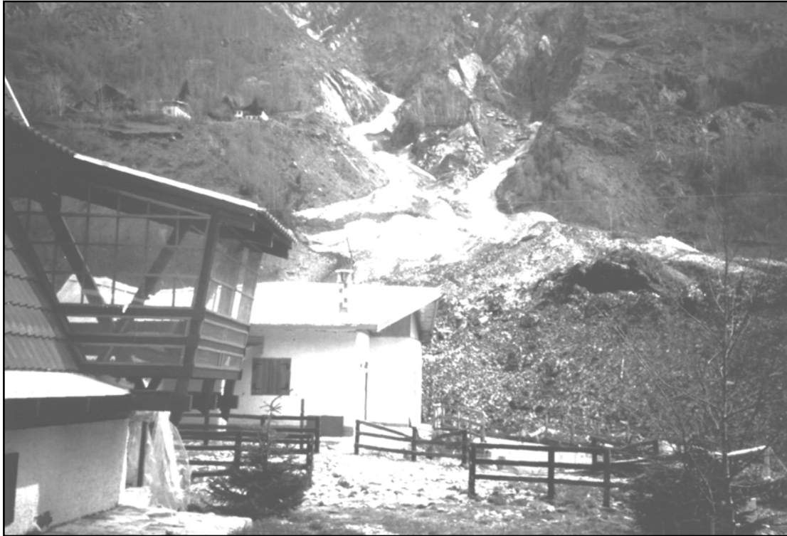
Fig. 23b. Comune di Riva Valdobbia. Danni provocati dalla valanga Rial dal Bin-Mezzana al villaggio Betulle. La massa nevosa sbarrò il corso del fiume Sesia che deviò le sue acque sul villaggio.
