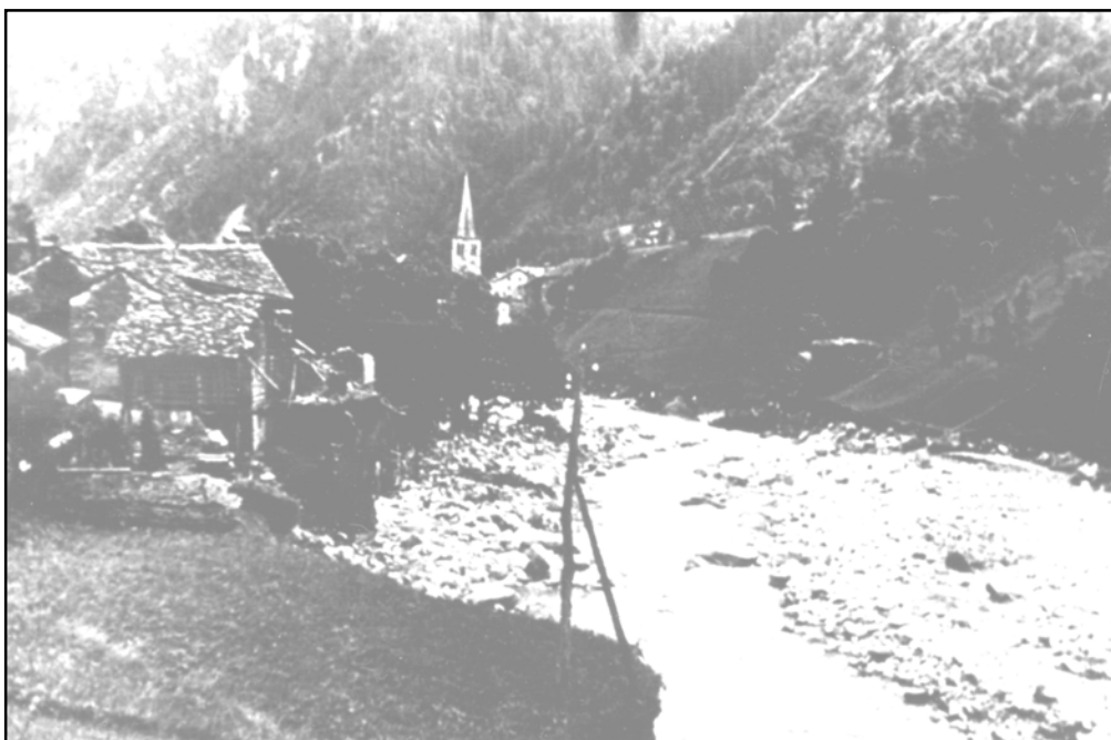
Fig. 13. Comune di Alagna. Sopra la frazione Ponte dopo l'alluvione del 1948. Tre case vennero distrutte dalla piena del F.Sesia.
