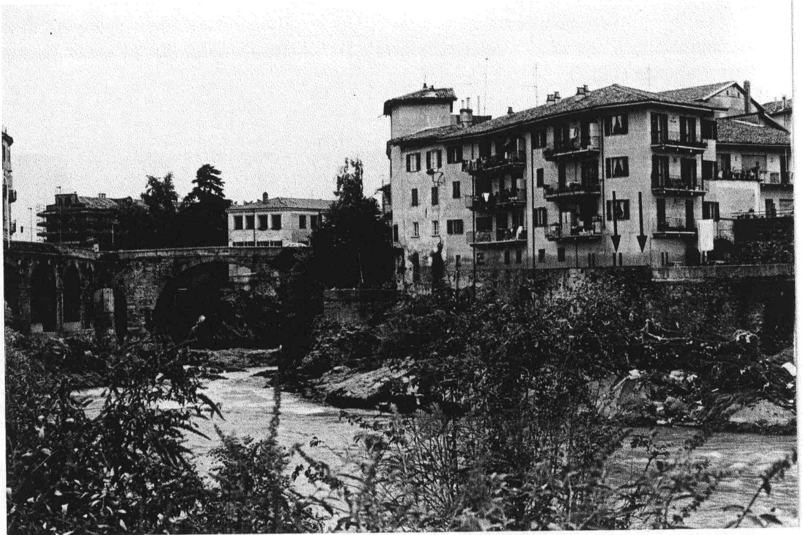
Fig.8 - Ivrea: le frecce indicano il livello raggiunto delle acque in corrispondenza degli edifici a monte del ponte Vecchio.
