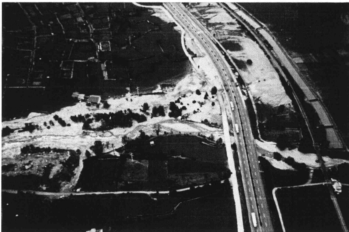
Fig.14 - Conoide del Torrente Renanchio, settore di raccordo con fondovalle. sono visibili in sponda sinistra le due abitazioni lesionate, la strada comunale alluvionata e l'espansione della colata nel tratto compreso tra l'autostrada ed il canale artificiale.
