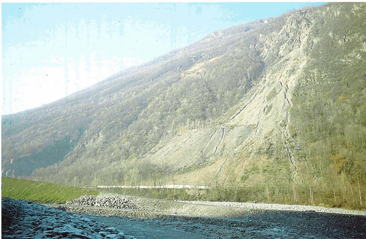
**Fig. 20.** Vue de la partie inférieure du site depuis la déviation de la Route Nationale 91 : au centre le cône d'éboulis actif, au premier plan La Romanche dans le chenal de déviation réalisée en 1986.
