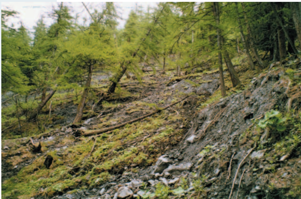
Figura 3.48 ◆ Aspetto del corpo di frana.
