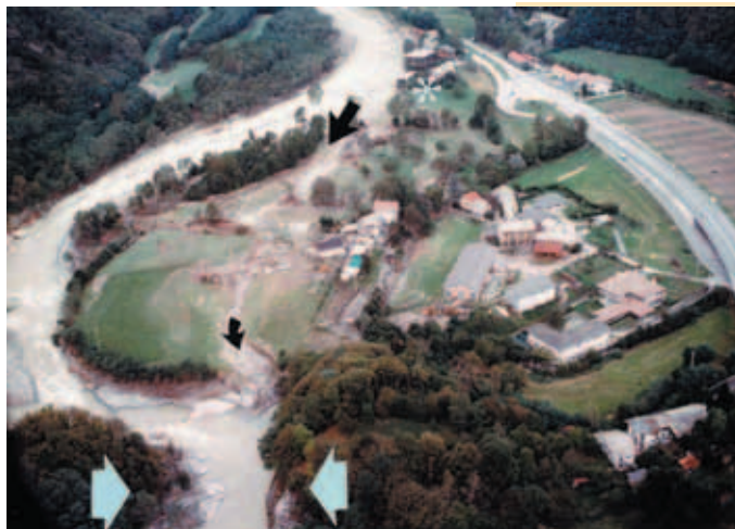
Figura 2.64 ♦ Pont Canavese, loc. Pratidonio: l'immagine aerea mostra come durante la piena del 1993 si siano innescate un'erosione a carico della sponda sinistra con minaccia ad alcuni edifici (asterisco) e la tracimazione delle acque che, nel loro percorso (freccie nere), hanno causato la distruzione di un capannone.
