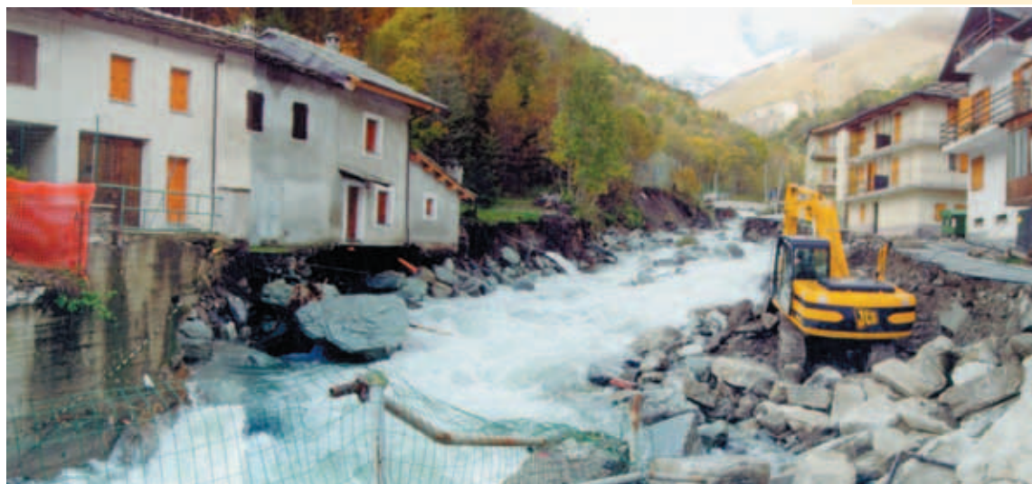
Figura 2.145 ◆ Comune di Crissolo, capoluogo. Il Po si amplia con erosione delle sponde in destra ed in sinistra, asportando strade ed infrastrutture. Gravi danni ad alcune abitazioni (a sinistra nella foto), parzialmente private del piano di appoggio.
