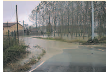
Figura 2.159 ◆ Comune di Crescentino. Allagamento in frazione Santa Maria
