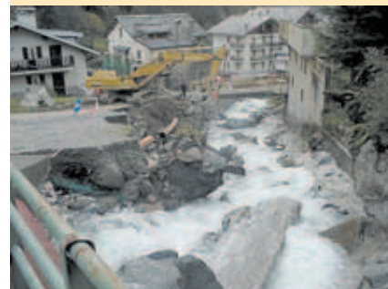
Figura 2.21 ◆ Comune di Alagna Valsesia - Strada comunale per Dosso - La piena del torrente Olen asporta in sinistra la carreggiata stradale per Dosso.
