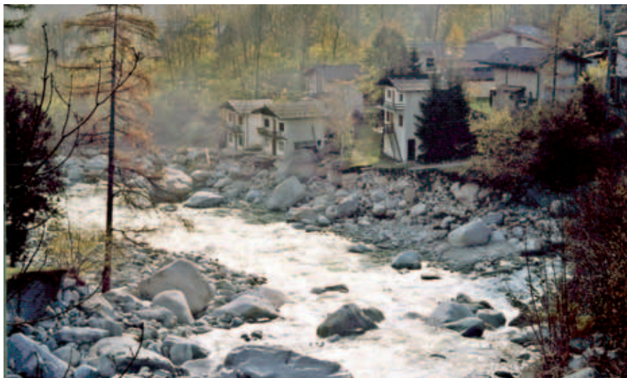
Figura 2.72 ◆ Ronco Canavese, Villaggio Betassa: appena a valle della confluenza del torrente Forzo, l'intensa azione erosiva ha provocato la completa distruzione di due abitazioni.
