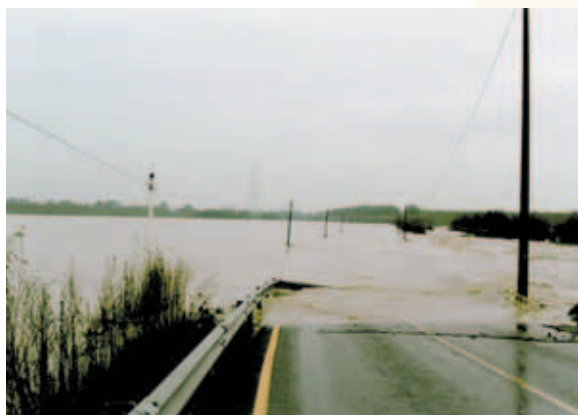
Figura 2.164 ◆ Isola S. Antonio, Guado S.S. 211. Acque di piena sul guado provvisorio realizzato a seguito dell'evento del novembre 94.
