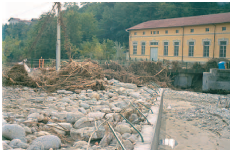
Figura 2.76 ♦ Comune di Cuorgnè, località Ponte Vecchio. Torrente Orco. L'edificio della Centrale, il canale di presa delle acque dall'Orco e i nuovi capannoni dell'area artigianale mostrano il pesante coinvolgimento indotto dal grossolano alluvionamento della zona.
