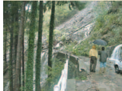
Figura 2.24 ◆ Comune di Boccioleto. Un fenomeno franoso interrompe la viabilità di fondovalle poco prima di Boccioleto isolando l'alta valle Sermenza.
