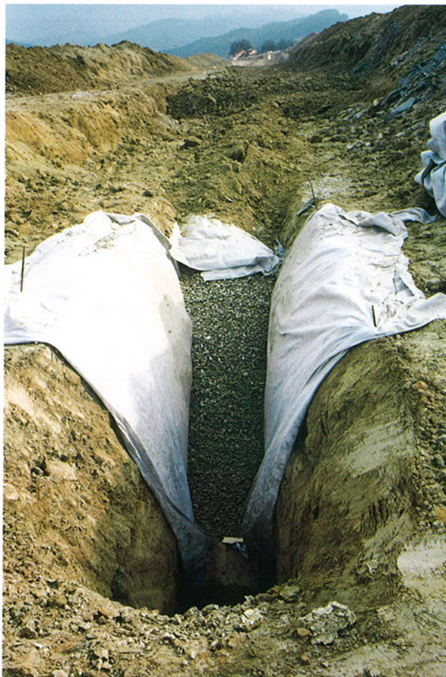
Fig. 10. Dogliani, loc. Pianezzo. Interventi in corso di esecuzione (foto V. Peisino).
