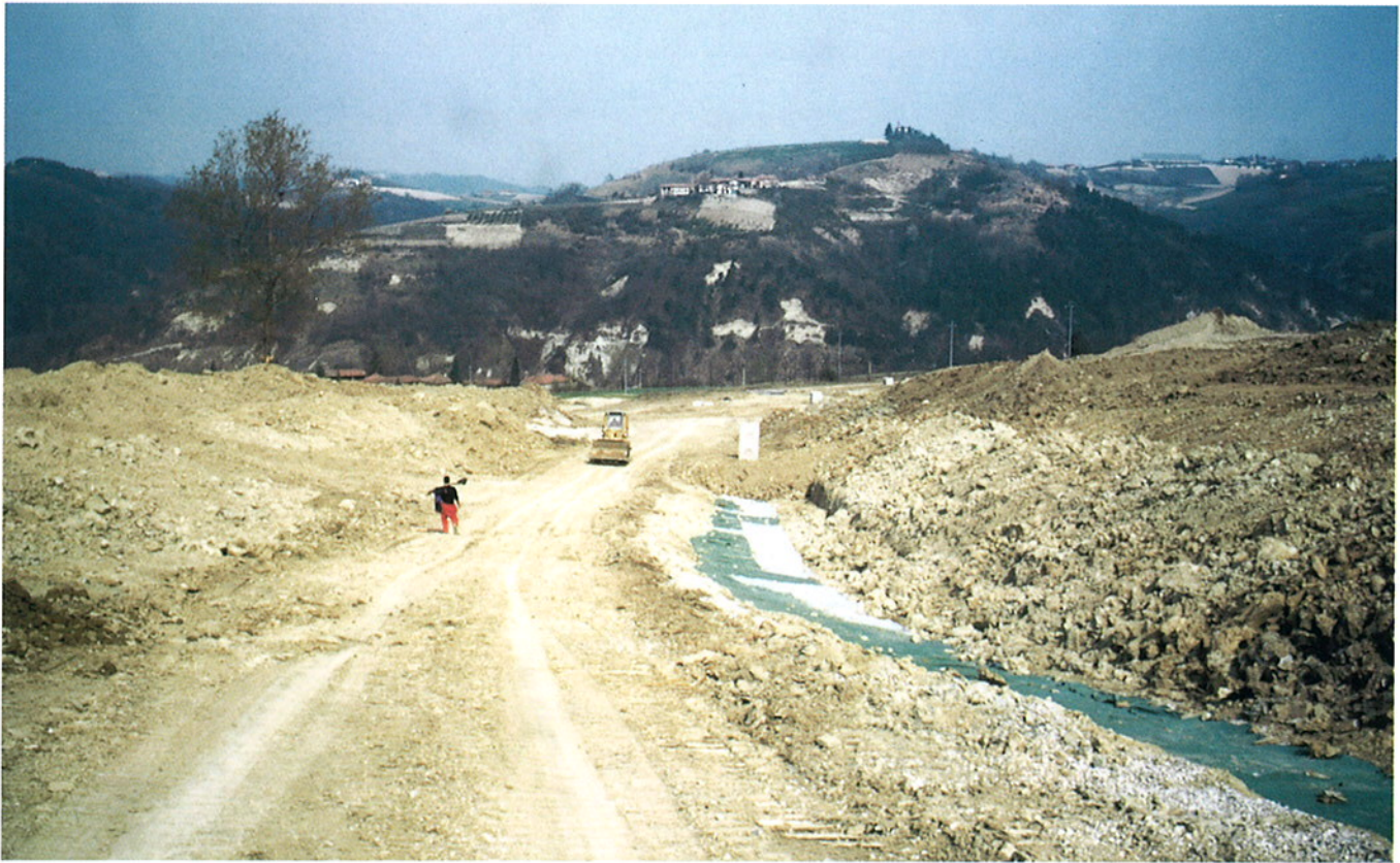
Fig. 11. Cissone, loc. Pianezza. Interventi in corso di esecuzione.
