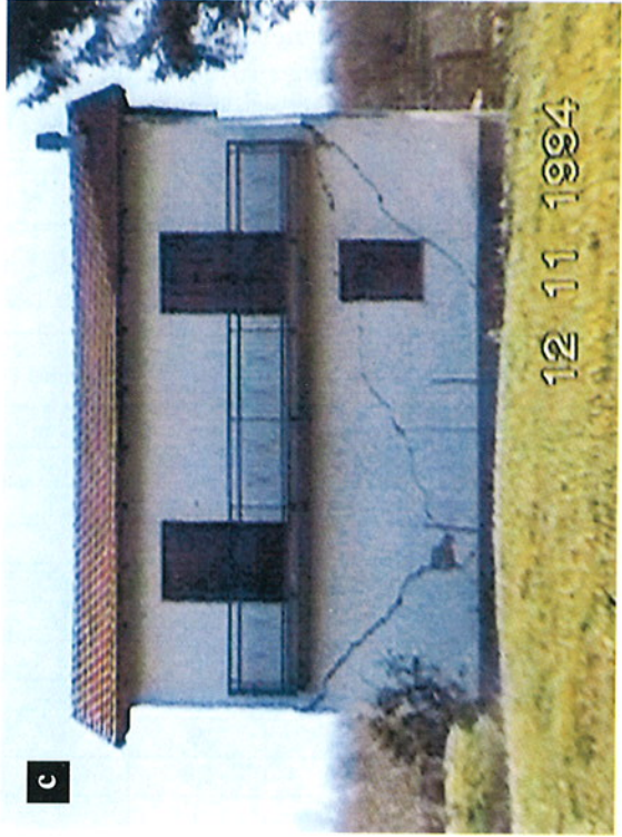
Fig. 35 bis. Frane per scivolamento planare nelle Langhe. Danni a manufatti: a) lesioni a carico della soletta e della parete interna di un edificio coinvolto da un movimento franoso; b) vistosa deformazione di un edificio ad uso agricolo, evidenziata dalla curvatura del colmo del tetto; c) gravissime lesioni ad un edificio che, durante il movimento franoso, ha subito una traslazione superiore a 40 m; d) la scarpata principale di un grande movimento incipiente ha seriamente coinvolto un edificio come è evidenziato, in questa ripresa aerea obliqua, dalla frattura che attraversa il cortile (al centro dell'immagine).
