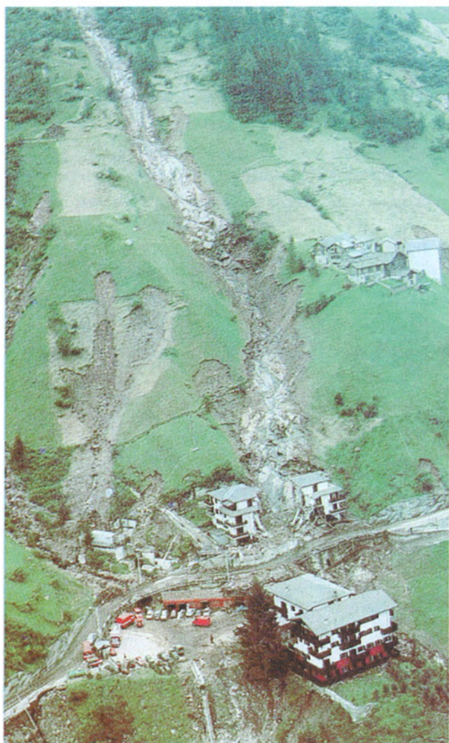
Fig. 66. Lombardia, Valtellina. Loc. Val Tartano (17-7-1987). Danni gravissimi ad edifici con numerose vittime a seguito di colata rapida incanalata di materiale derivante da frane di mobilitazione della coltre detritica (Catenacci, 1993).
