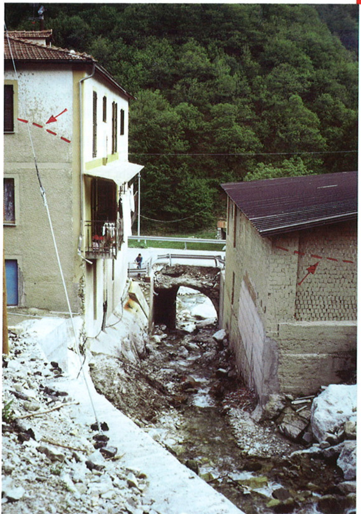
Fig. 1. Comune di Frabosa Soprana, torrente Corsaglia, rio Camperi. Il passaggio impulsivo di un'onda di piena, verosimilmente formata per cedimento di effimeri sbarramenti, ha lasciato evidenti segni su edifici prossimi all'alveo.
