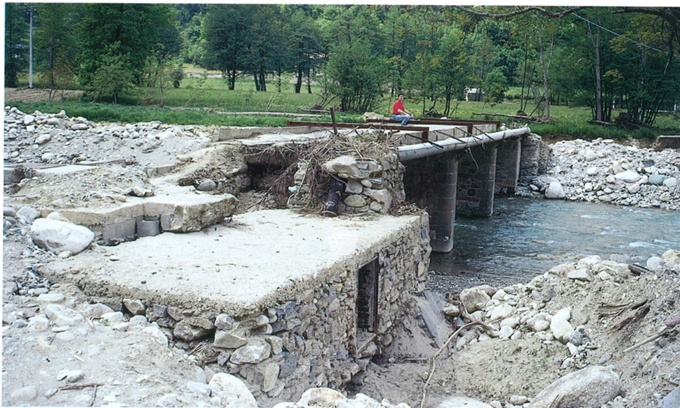
Fig. 14. Torrente Corsaglia, località Molline. L'immagine documenta i pesanti danni sofferti dal ponte di accesso al centro abitato.
