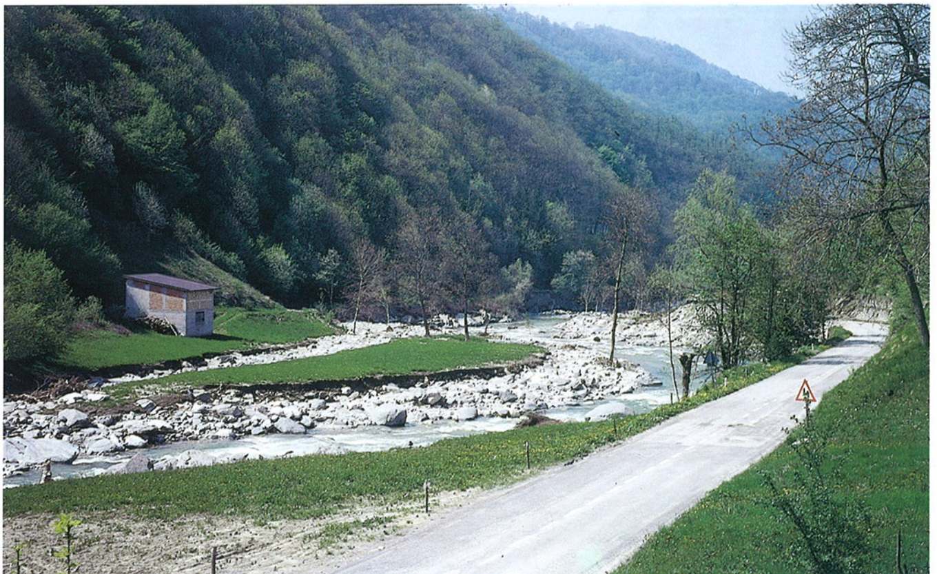
Fig. 8. Valle Corsaglia, tratto montano. La portata straordinaria sopportata dal torrente ha provocato ampia occupazione del limitato fondovalle con profonde forme erosive esterne all'alveo ordinario. La vicinanza della strada di fondo valle al torrente ha visto il verificarsi di ripetute interruzioni dell'arteria per erosioni laterali.
