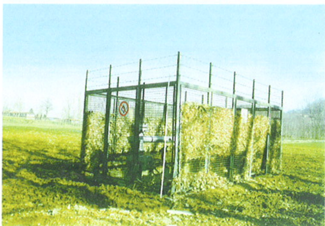
Fig. 20. Comune di Asti. Torrente Borbore. Centralina del metanodotto alluvionata presso Revignano; l'altezza dell'acqua superava 1.5 m.
