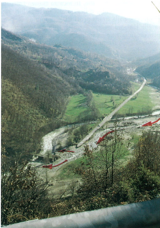
Fig. 12. Torrente Corsaglia, località Gorrazzi. Nella ripresa, da valle verso monte, sono visibili gli effetti dell'erosione e del conseguente disalveamento (margine destro della figura). Gran parte della piena torrentizia ha così determinato la creazione di un canale esterno all'alveo con distruzione di lungo tratto della strada provinciale e dell'accesso al ponte, in primo piano.
