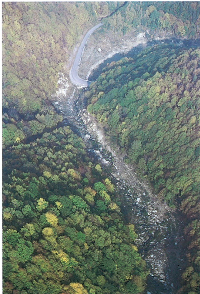
Fig. 17. Rio Castorello, tratto superiore. Immagine aerea dell'asta torrentizia con gli evidenti segni laterali del passaggio della colata detritica che, in corrispondenza dell'attraversamento ha asportato oltre 60 m di strada.
