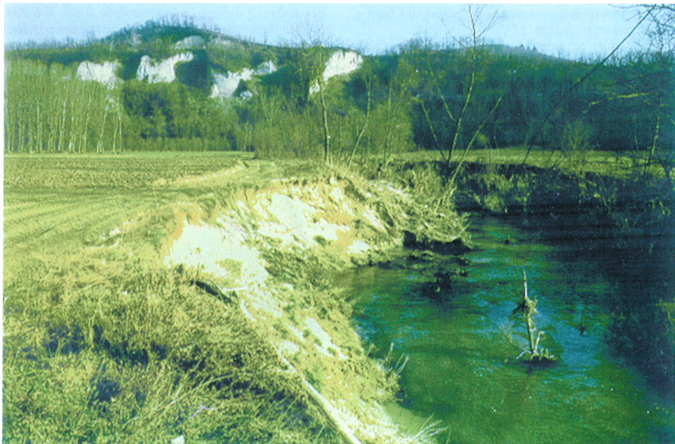
Fig. 19. Comune di Asti. Torrente Bobore. Erosione in sponda sinistra a monte di C. Palazzetto.
