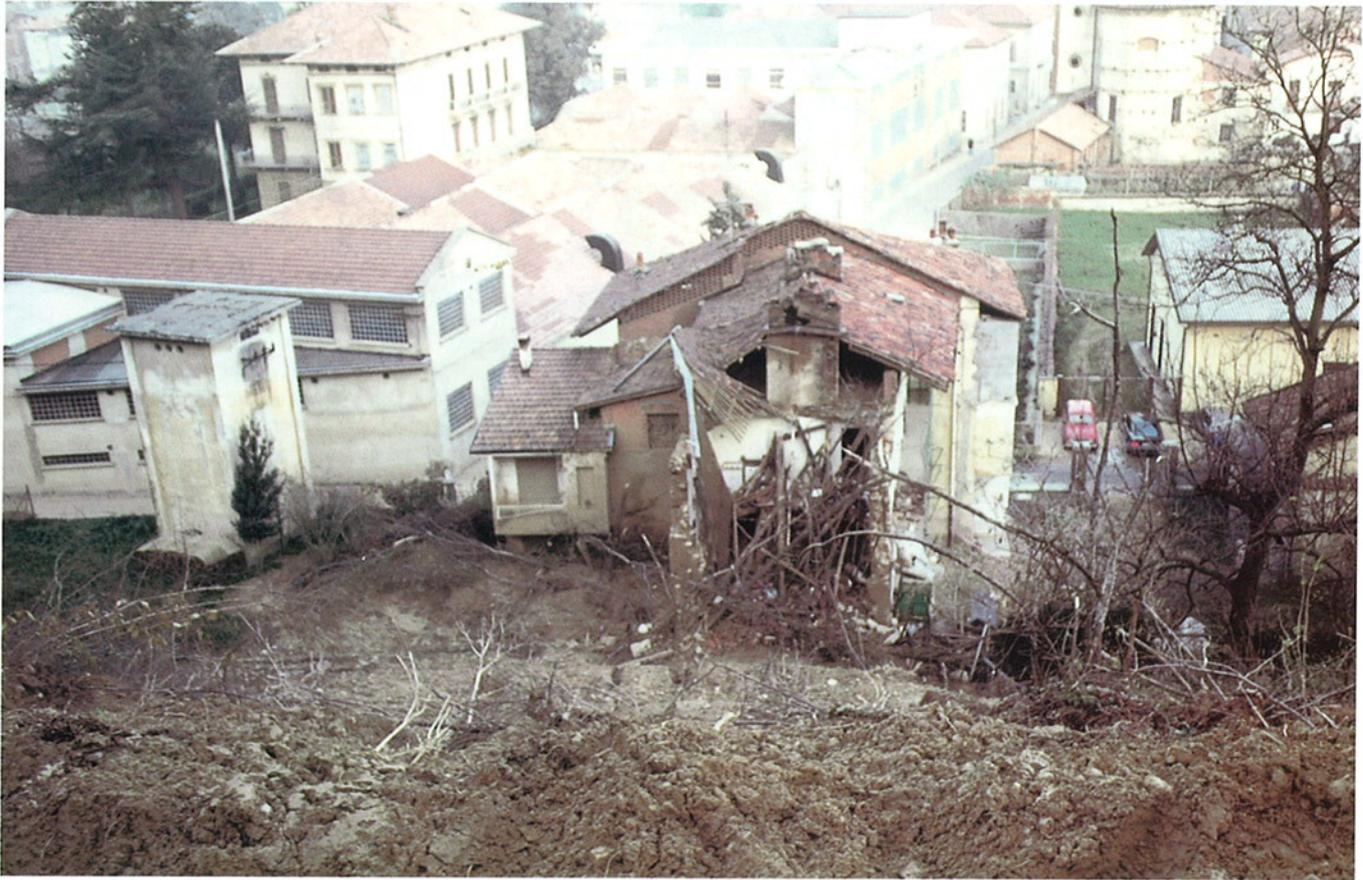
**Fig. 34.** Comune di Mongrando, fr. Ceresane: vista da monte dell'accumulo di frana costituito da materiale limo-sabbioso che ha raggiunto e distrutto la parte posteriore dell'edificio.
