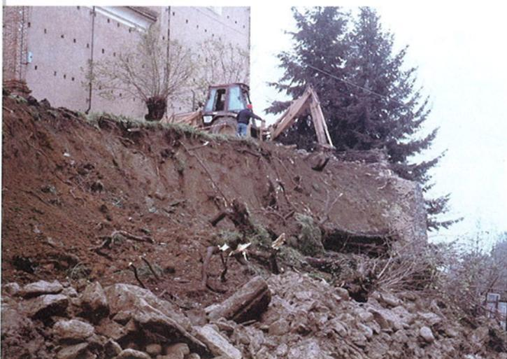
**Fig. 42.** Comune di Mongrando, loc. San Lorenzo: collasso del muro di sostegno del piazzale della Chiesa; il materiale franato ha interrotto la sottostante strada interrompendo l'accesso alla frazione.
