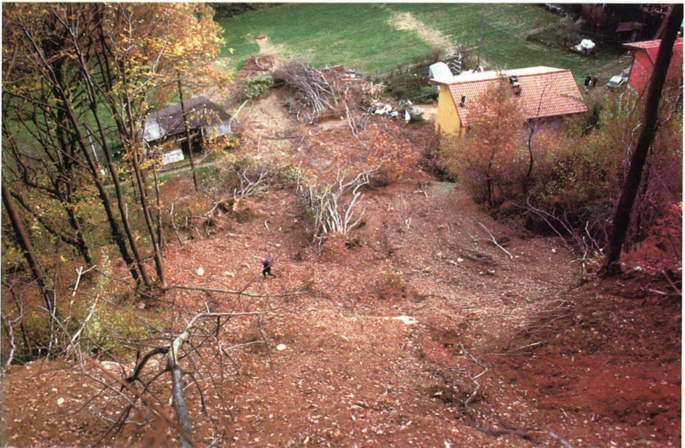
Fig. 36. Comune di Mongrando, loc. Briengo: vista da monte di una delle case colpite dalla colata di materiali sabbioso-limosi; parte della frana supera l'edificio e si disperde sul prato.
