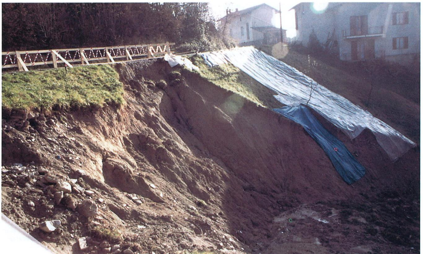
Fig. 33. Comune di Biella, loc. Bogna: frana innescatesi sul ciglio di valle della strada, con asportazione di parte della carreggiata. Tipologia di frana ricorrente, generalmente imputabile a problemi di smaltimento delle acque di ruscellamento.
