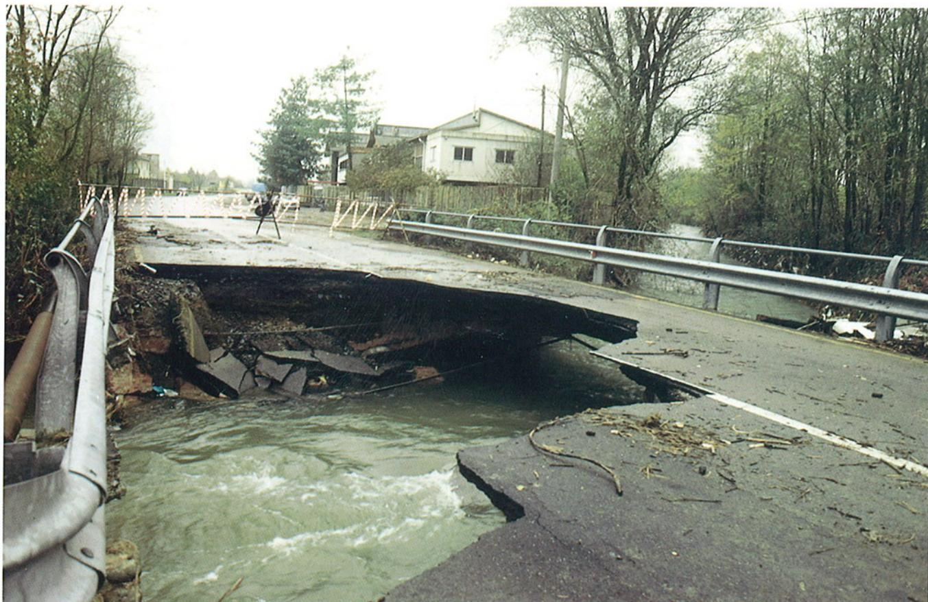
Fig. 24. Comune di Volpiano. Ripresa da Est dell'attraversamento sul t. Bendola, lungo la strada astatale tra Volpiano e Leinì, gravemente danneggiato dalle acque di piena del torrente.
