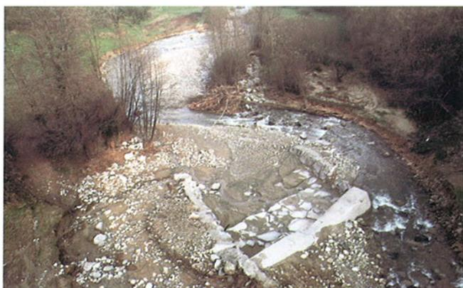
**Fig. 40.** Comune di Mongrando, loc. S.S. 419 Settimo-Vittone: vista dal viadotto dell'alveo del t. Viona, a monte della frazione Tana; la foto evidenzia le profonde erosioni laterali e la mobilizzazione dei materiali in alveo. Particolare non secondario l'insufficiente dimensionamento dell'alveo testimoniato dalla presenza di una briglia con le sue difese laterali.
