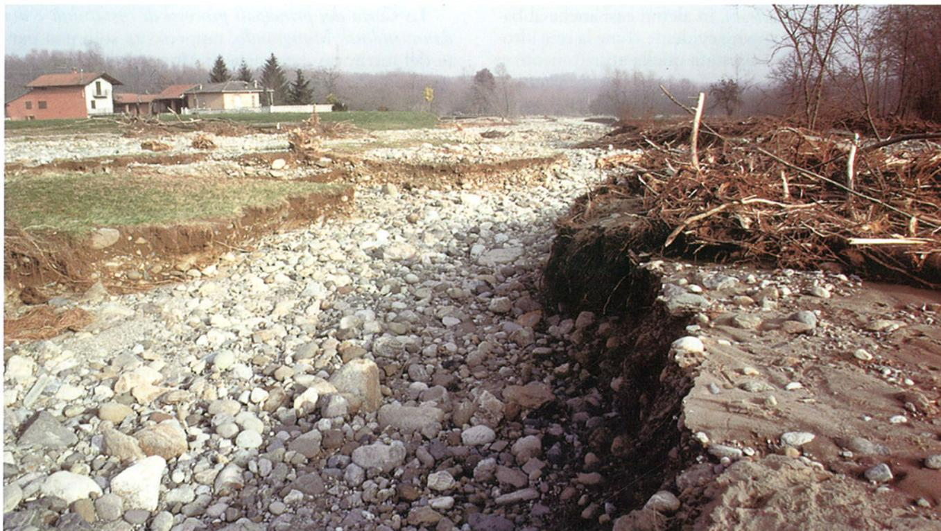
**Fig. 39.** Comune di Cerrione, loc. M. Vianzé: vista da monte del nuovo canale creato dal disalveamento del rio della Sorda; sullo sfondo a sinistra i depositi di materiale grossolano e la cascina evacuata durante l'evento.
