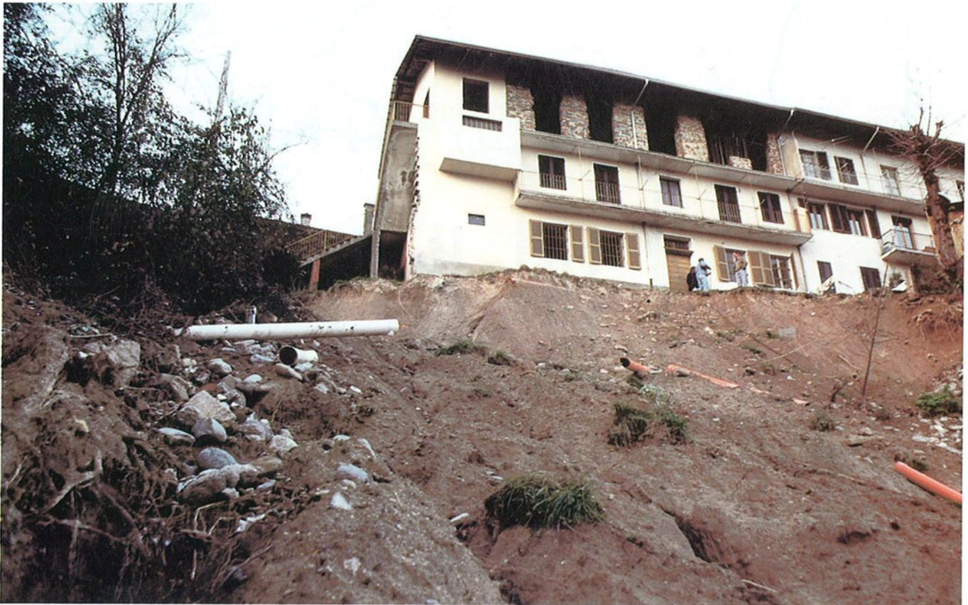
**Fig. 35.** Comune di Portula, loc. Scatolè: vista da valle della zona di distacco della frana al piede della casa; asportate le pertinenze e seriamente compromessa la stabilità dell'edificio. La mobilizzazione dei rilevati artificiali è un fenomeno piuttosto ricorrente quando connesso a problemi di instabilità di aree prospicienti gli edifici.
