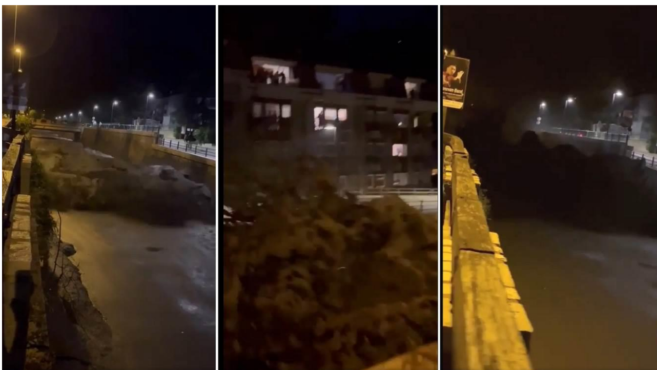
Figura 16 – Fotogrammi della ripresa dell'arrivo della colata, tratto dalla pagina Facebook "Meteoinpiemonte" di Andrea Vuolo; la colata si è sviluppata in più fasi, nell'arco di un paio di minuti, di cui le prime a maggiore componente liquida (a sinistra ed in centro) e le successive a maggiore componente grossolana (a destra).
