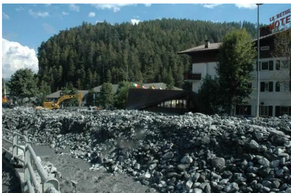
Figura 30 – A sinistra, accumulo di materiale grossolano a monte del ponte di via Stazione e coinvolgimento dell’Hotel la Betulla e, a destra, visto dal lato di Viale della Vittoria dove l’accumulo è stato prevalentemente di granulometria fine.
