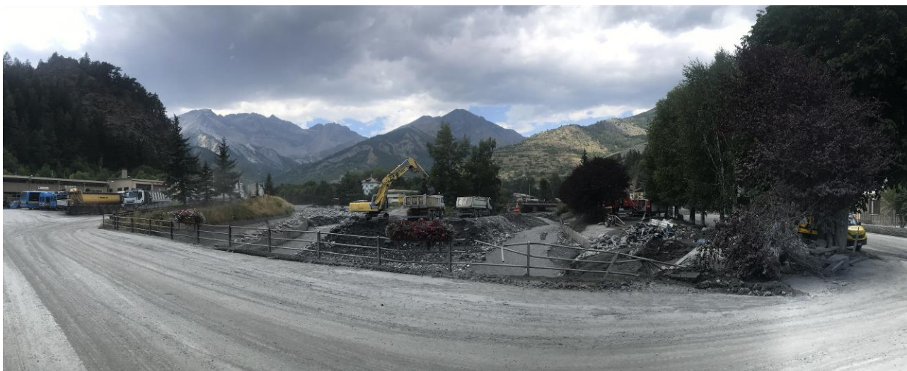
Figura 35 – Panoramica verso monte dall'attraversamento della caserma dei VVFF.
