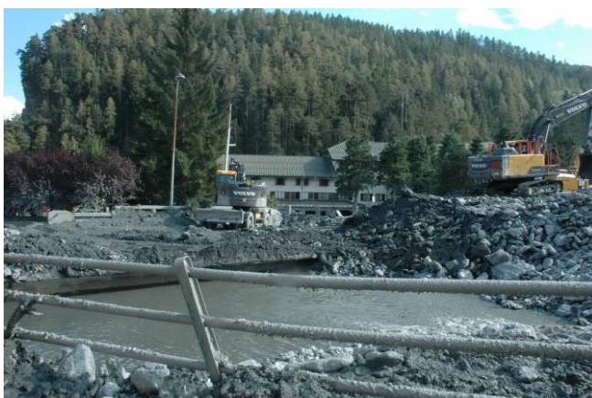
Figura 25 – Ponti di via Stazione (a sinistra) e di via Torino (a destra) completamente occlusi, nelle foto rispettivamente del 14 agosto e del 16 agosto dopo i primi interventi di ripristino.
