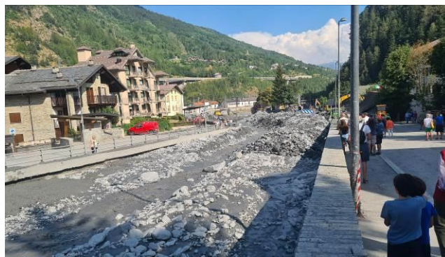
Figura 24 – A sinistra: il ponte di via Montenero, visto da monte, privato totalmente del corrimano. A destra: alveo intasato di materiale detritico a valle del ponte di via Montenero.
