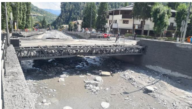
Figura 24 – A sinistra: il ponte di via Montenero, visto da monte, privato totalmente del corrimano. A destra: alveo intasato di materiale detritico a valle del ponte di via Montenero.
