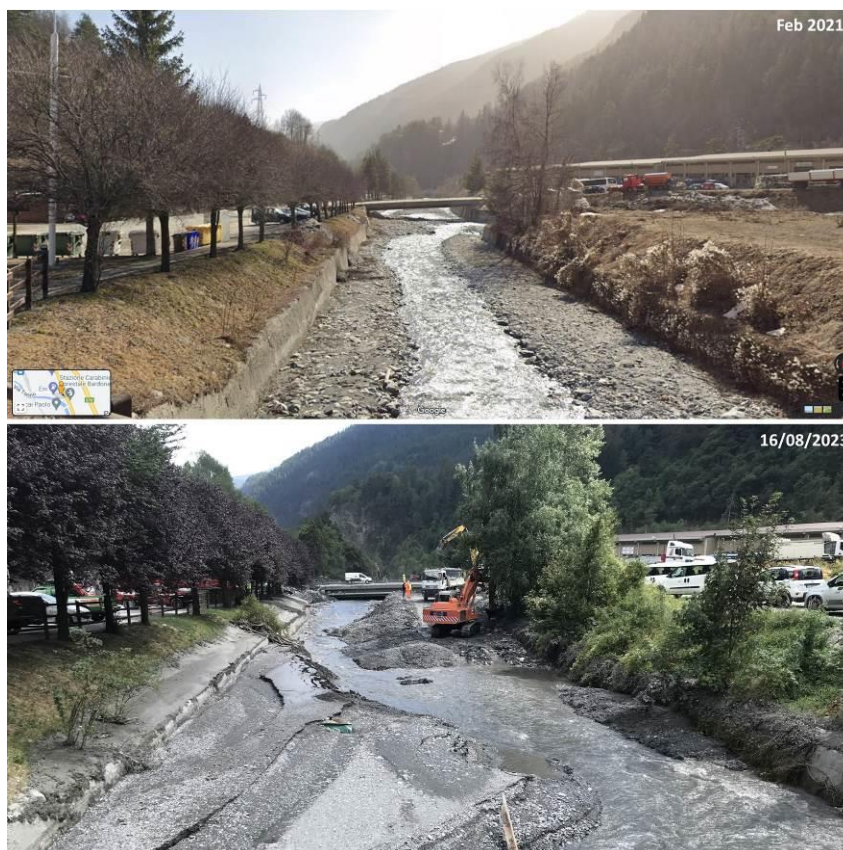
Figura 34 – Ponte caserma VVFF, confronto 2021 (immagine Google) e 2023 post evento: accumulo plurimetrico di materiale in alveo e quasi completa occlusione della luce del ponte.
