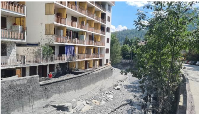
Figura 21 – Edificio in sinistra idrografica posto poco a valle del ponte di Via Medail interessato dalla colata detritica. Gli stessi edifici erano stati lambiti dalla colata del 2009.
