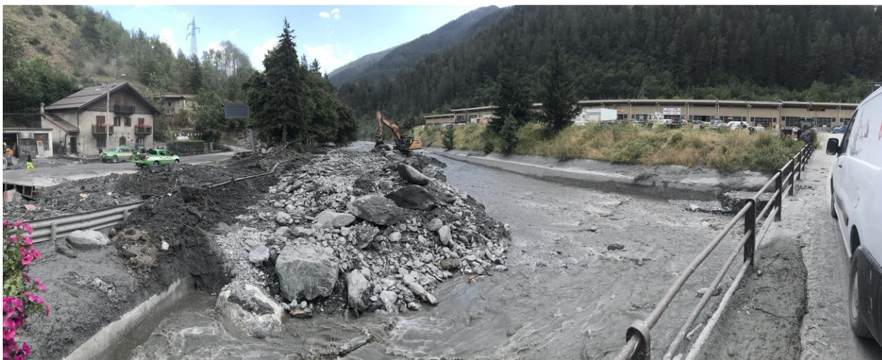
Figura 36 – Panoramica verso valle dall'attraversamento della caserma dei VVFF.
