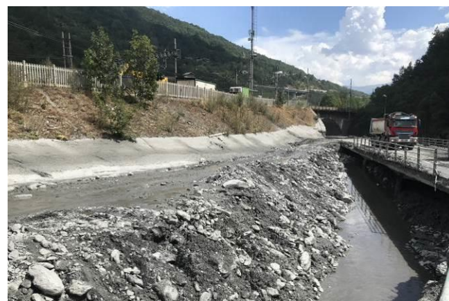
Figura 25 – Ponti di via Stazione (a sinistra) e di via Torino (a destra) completamente occlusi, nelle foto rispettivamente del 14 agosto e del 16 agosto dopo i primi interventi di ripristino.
