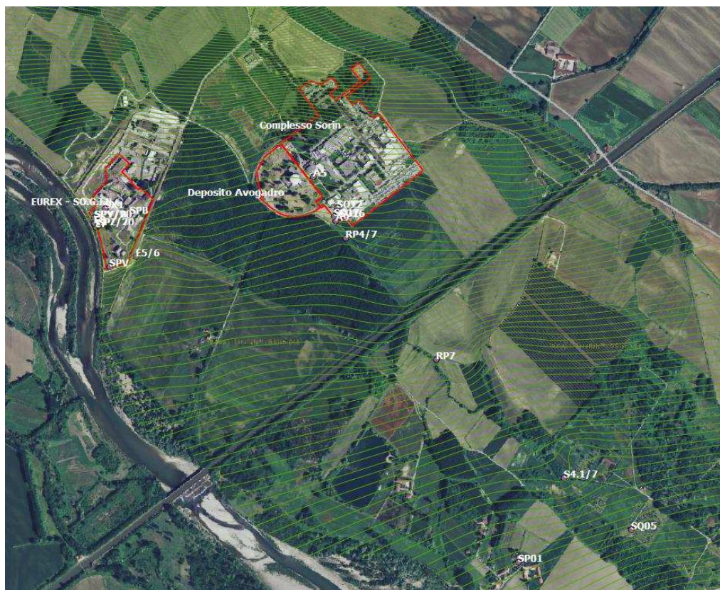
Figura 1 Distribuzione dei punti di prelievo dell'acqua di falda nel Comprensorio nucleare di Saluggia (VC).
